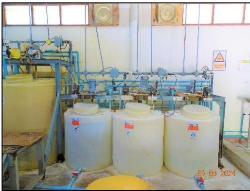
ภาพถ่ายที่ 2.2-36 ถังเติมคลอรีนฆ่าเชื้อโรค
