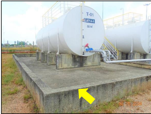
ภาพถ่ายที่ 2.2-25 คั่นกำแพงคอนกรีตป้องกันน้ำมันรั่วไหล
